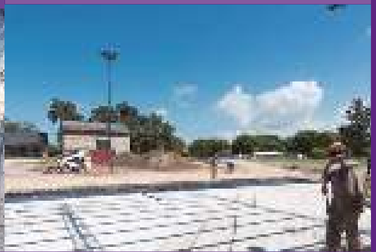
Obras en la nueva terminal de ómnibus de la localidad de Verónica, Punta Indio.
