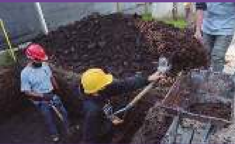
Obras en el Complejo Deportivo y Cultural Néstor Kirchner, Quilmes.
