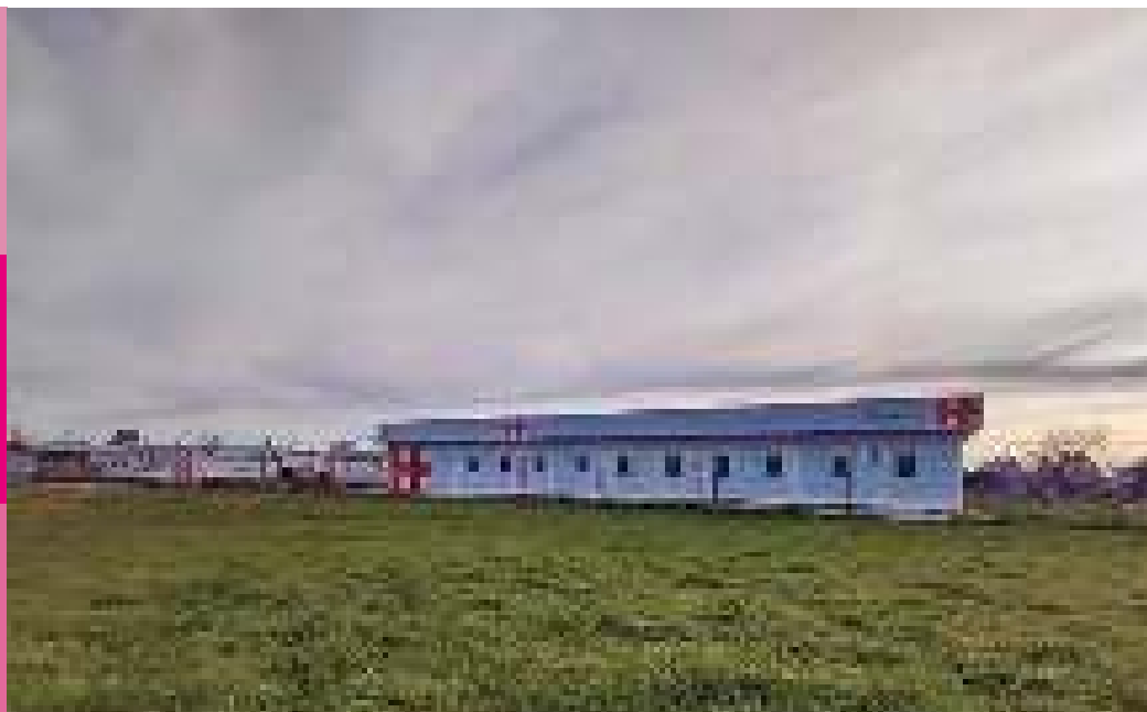
El Hospital Modular 12, inaugurado en julio de 2020, fue emplazado en el predio del Hospital Interzonal General de Agudos de Mar del Plata y cuenta con una superficie de 1.100 m 2 .
