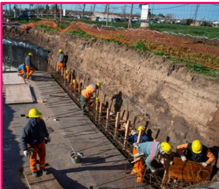
Cartelería de obra no sexista
